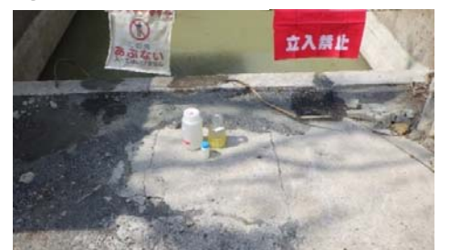
④ 事務所前調整槽
