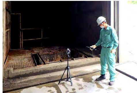
有害ガス測定
