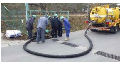
吸引車による油の回収
